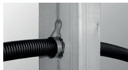
Tre røret inn i spikeravviseren og fest det med fikseringsklammeret.
