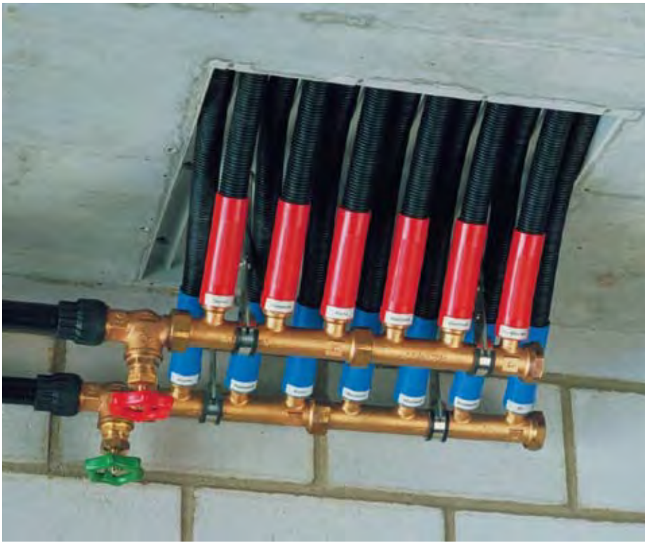
Et eksempel på overgang fra Sanipex MT til Sanipex Classic
