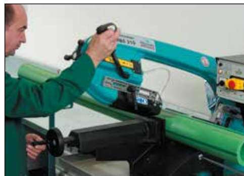
Kapp 160 mm røret i riktig lengde før sveisingen
