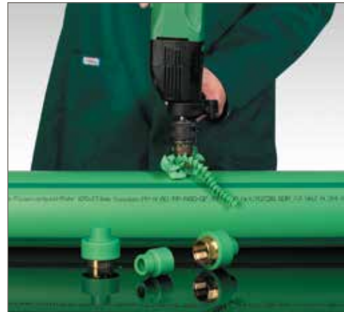
Gjennom boring av rørveggen
