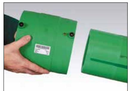
Trykk el-sveismuffen inn på rørenden
