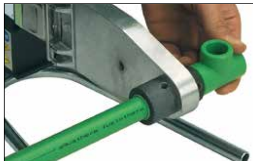
Oppvarming av rør og rørdel
