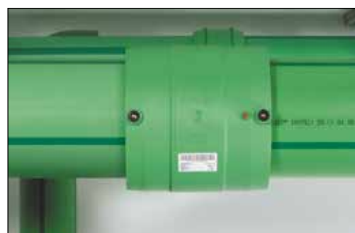
Den andre rørenden skrapes og skyves inn i muffen
