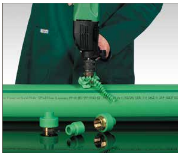
Gjennom boring av rørveggen
