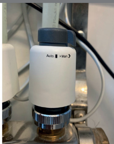
Elektrotermisk aktuator i MANUELL posisjon
