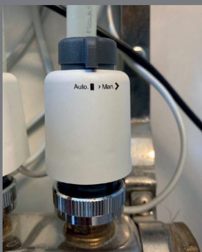
Elektrotermisk aktuator i AUTO-posisjon
